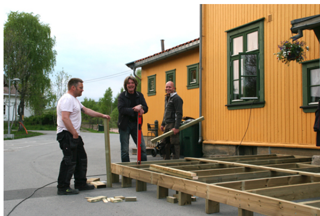
Her ser vi litt fra byggingen av uteplassen.
